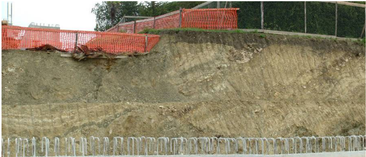
Fig. 1.3 - Affioramento del flysch di Faeto nella zona Sud del centro abitato (foto eseguita durante i lavori di ricostruzione).
