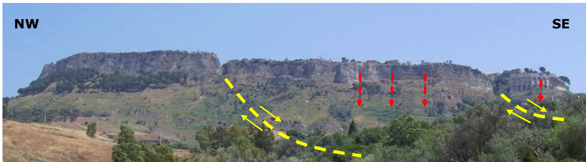
Fig.2.3.10 Vista panoramica della rupe di Gerace e evidenze dell'instabilità dell'area.
