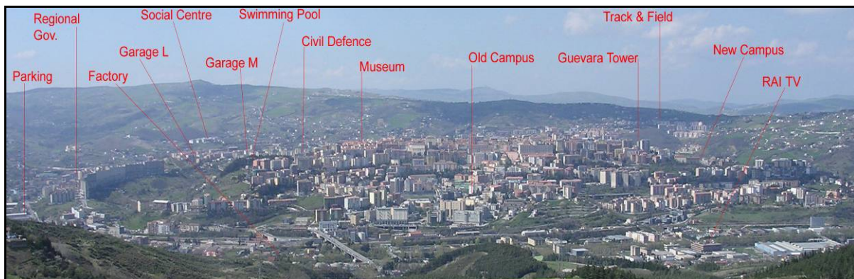
Figura 1.1.1. Collocazione delle Stazioni GFZ nel Centro Urbano di Potenza
